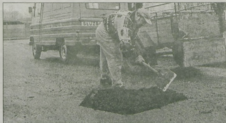
Prace drogowe na ul. Klemczaka
