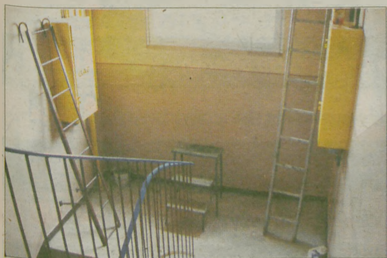
Prace instalacyjne w blokach przy ulicy Topolowej jeszcze trwają, ale w mieszkaniach jest już ciepło
