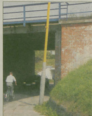
Wyjazd z ul. Ceglanej na al. Niepodległości
