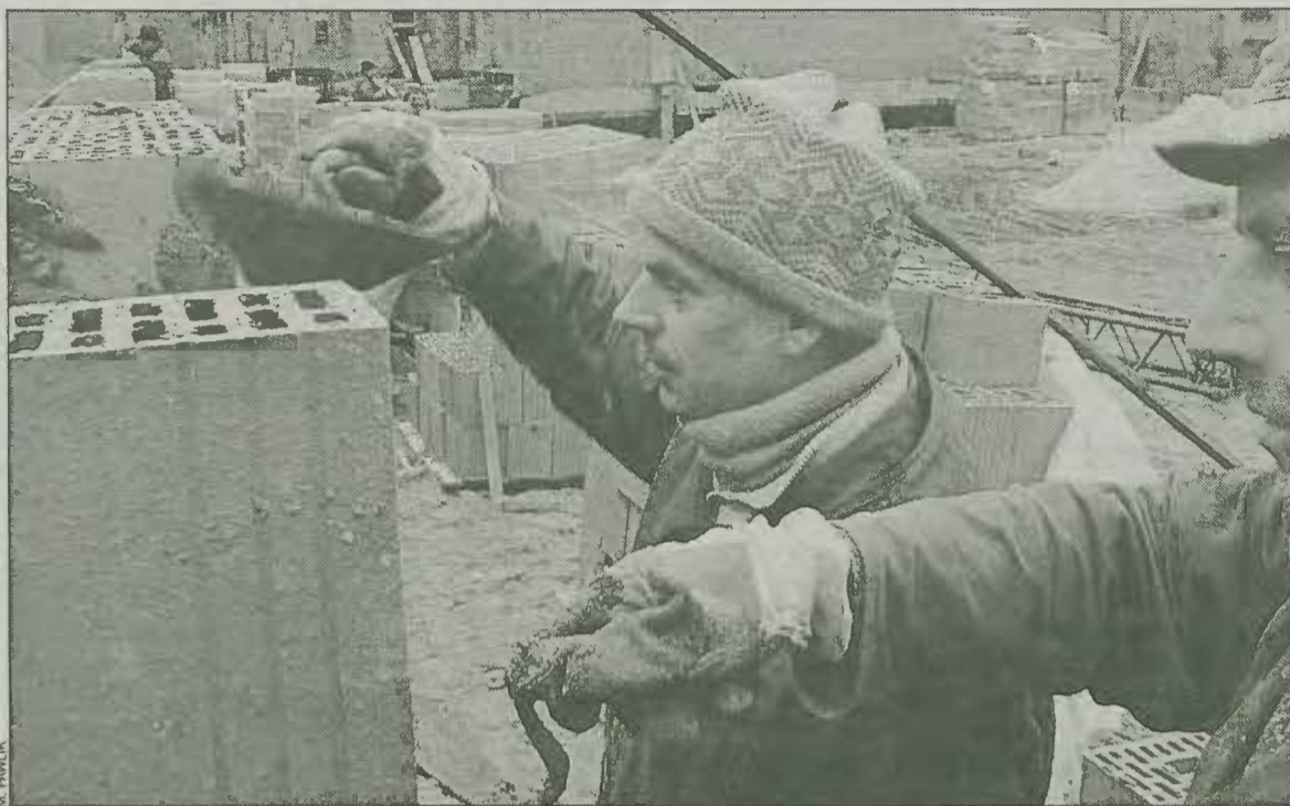
Prace przy rozbudowie SP nr 3
