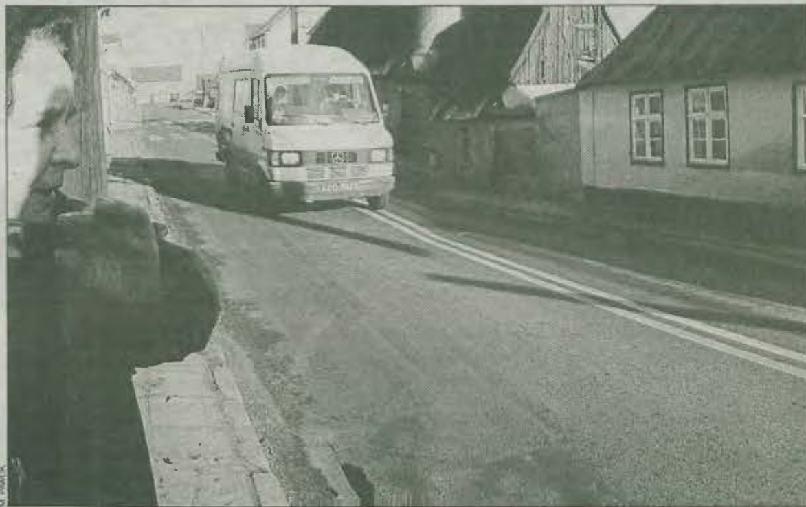
Widoczny po prawej dom Rozalii Jajor był malowany ledwie rok temu
