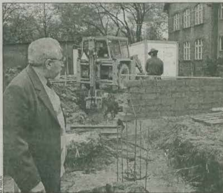
Dyrektor Wygralak okiem gospodarza spogląda na plac budowy
