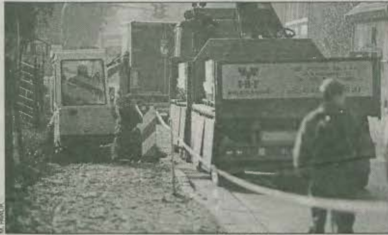
Trwa przebudowa ul. Sienkiewicza
