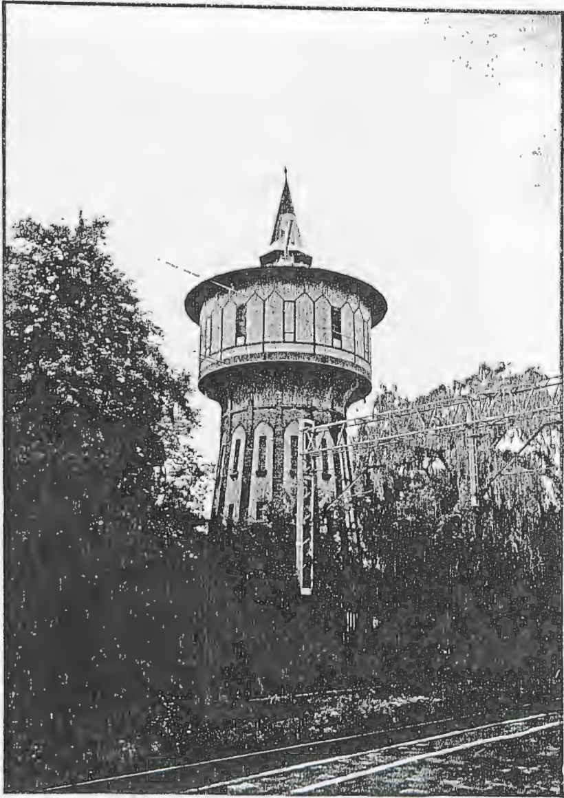
Kolejowa wodociągowa wieża ciśnień w Ostrzeszowie, otoczona pięknym drzewostanem.
