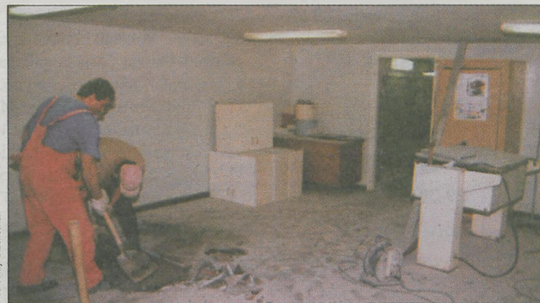
Trwają prace remontowe w kuchni Szkoły Podstawowej w Chociczy ...
