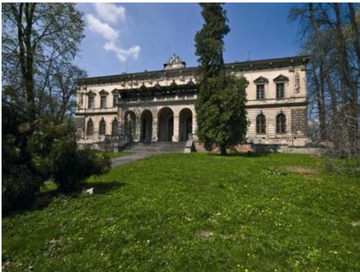
Pałac w Pilicy
