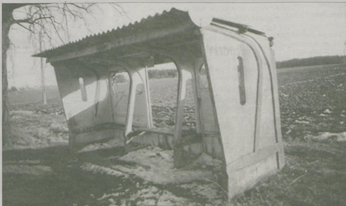
Przewidywany przystanek w Niedźwiadach (gmina Jaraczewo)
