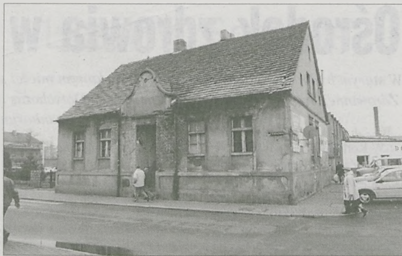
Ekspertyza wykazuje, że obiekt nadaje się tylko do rozbiórki, nie wiadomo jednak czy do niej dojdzie
