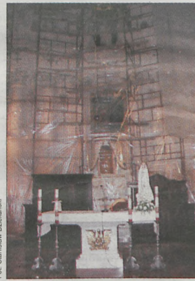
Prace w prezbiterium kościoła św. Marcina potrwać około trzech miesięcy boszcz parafii św. Marcina ma nadzieję, że uda je się zakończyć przed Świętami Wielkanocnymi.
