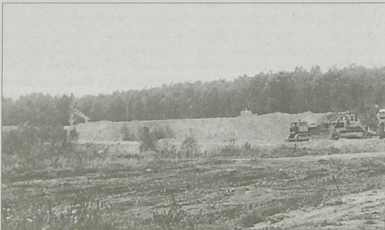
W gminie Żerków trwa rozbudowa wysypiska śmieci znajdującego się w Brzóstkowie. Fundusz przekazał na ten cel w 2000 roku 600 tys. zł
