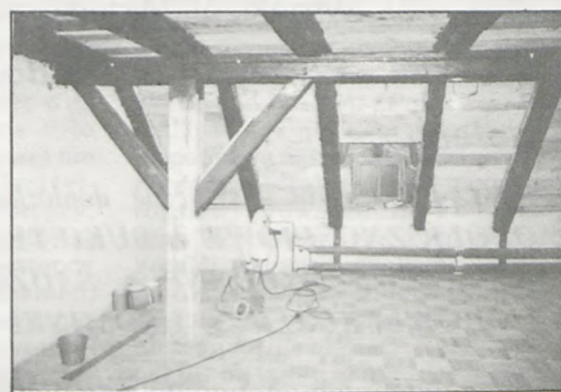
W całym obiekcie trwają prace wykończeniowe.
