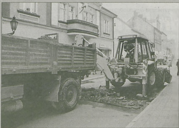
Od ubiegłego tygodnia prowadzone są prace remontowe na ul. Śródmiejskiej w Jarocinie. Będzie położony nowy dywanik asfaltowo - betonowy. Tak samo remontowane będą już wkrótce ulice Wolności, Kilińskiego, Średnia i Mickiewicza
