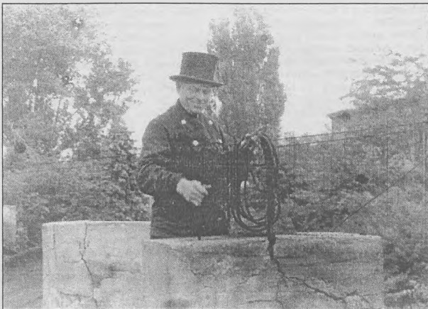
Kolejny komin do wyczyszczenia...
