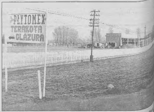
Za kilka miesięcy budowa zostanie zakończona. Centrum handlowe „Plytomex” będzie elegancką wizytówką miasta
