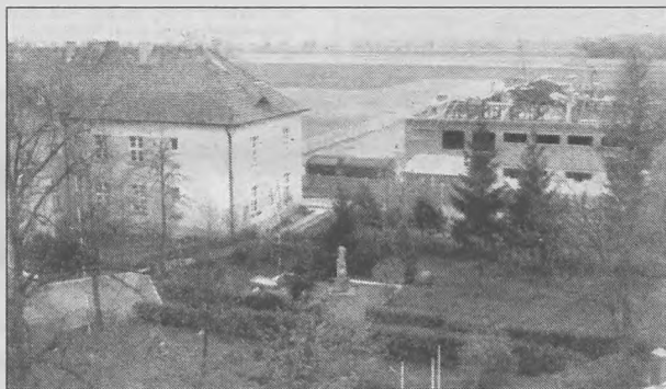
W tym roku ukończona zostanie budowa Przedszkola Samorządowego (widoczne go z prawej strony) i rozpoczęta budowa sali gimnastycznej przy Szkole Podstawowej w Przykonie (gmach z lewej strony)
