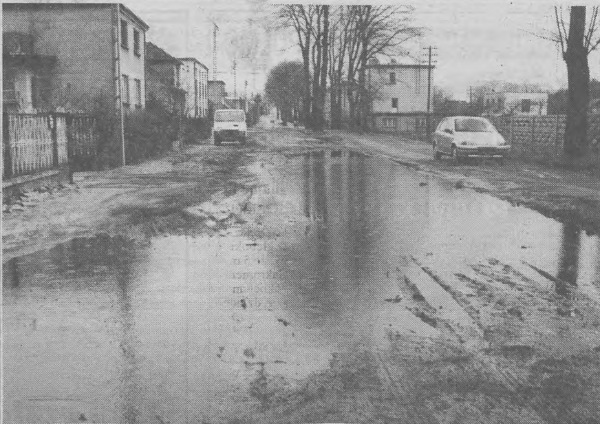
Tę fotografię nasz fotoreporter zrobił kilka dni temu. Przedstawia fragment ulicy Grzegorzewskiej, której mieszkańcy od lat, zwłaszcza wiosną i jesienią, toną w błocie. Podobnych ulic, o nieutwardzonej nawierzchni, wciąż jest w mieście wiele. Może ten problem rozwiąże nowa Rada Miejska?
