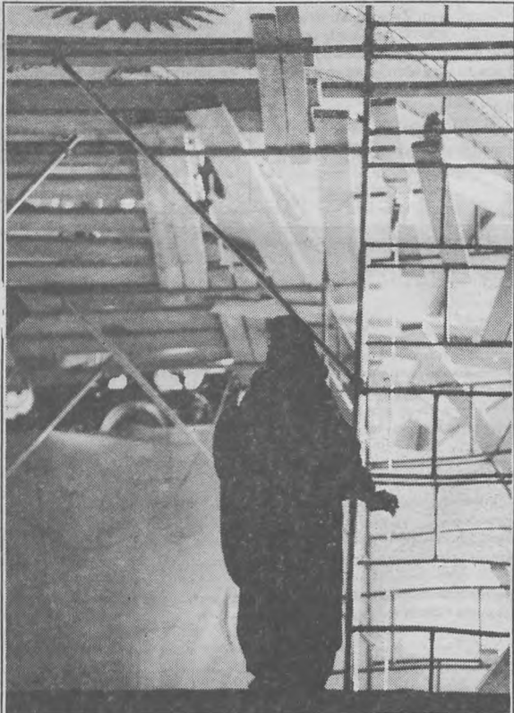
Fot. „Rzecz” - Pawlik Krotoszyński kościół farny w trakcie prac remontowych, które mają zakończyć się przed Niedzielą Palmową. Na pierwszym planie jedna z zabytkowych figur
