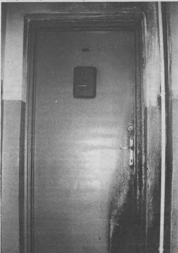
Fot. "Rzecz" - M. Pawlik Zniszczone drzwi
