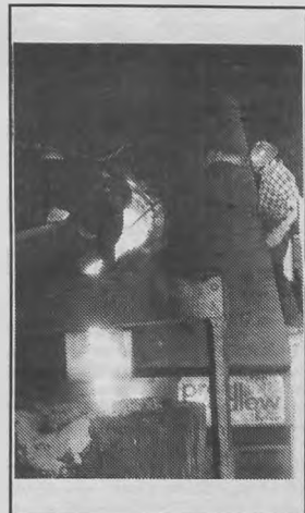
Spust żeliwa z pieca do kadzi
