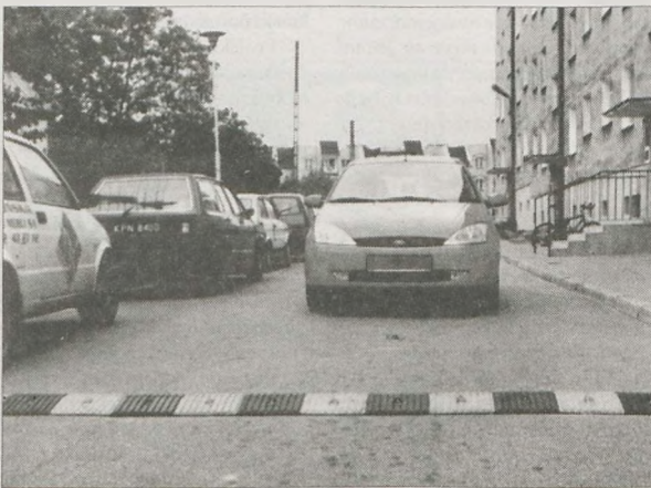
Dwa metalowe ograniczniki prędkości zamontowano na osiedlu przy ul. Kasztanowej. Muldy założono w odległości około 30 m od siebie
