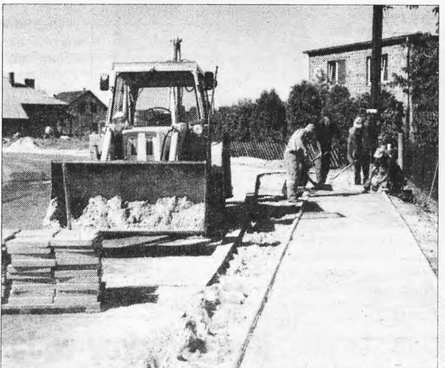
Trwają prace przy budowie chodnika w Annapolu, koło Jarocinie
