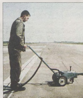
Urządzenie powiększające ubytki w płycie lotniska
