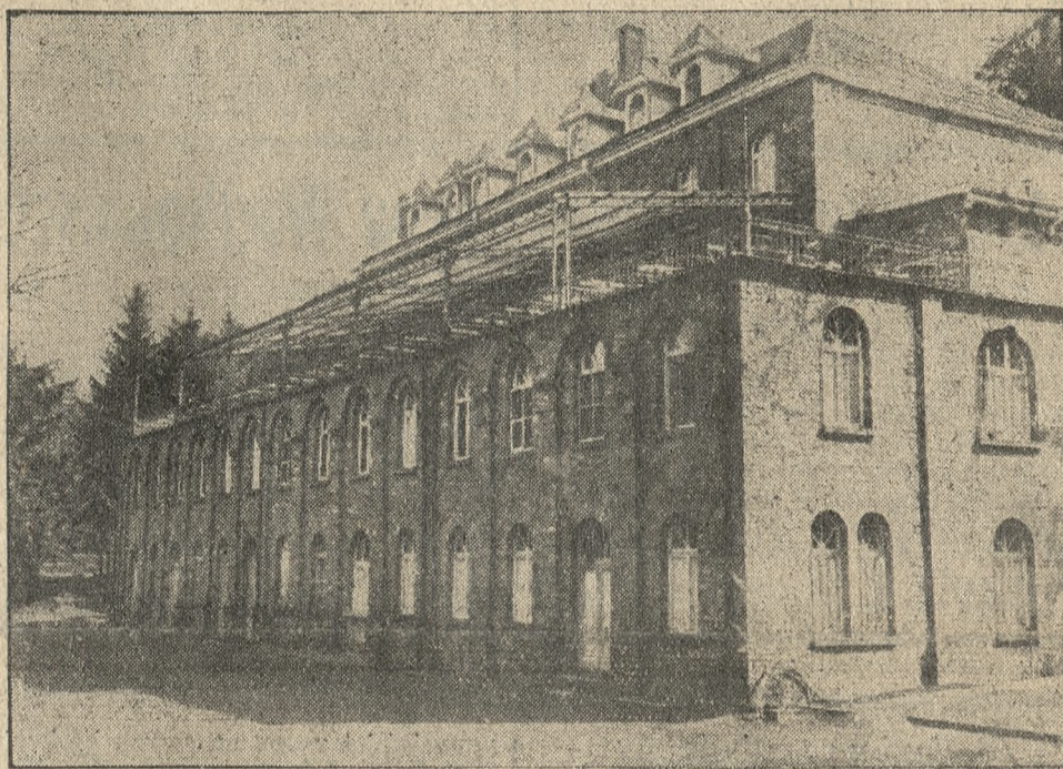
Przygotowania do Olimpiady w roku 1936. znajdują się już w Niemczech w pełnym tempie. Powyżej widzimy kwaterę główną, ulokowaną w rozbudowanym gmachu związku lekko - atletycznego w Ettlingen (Bawaria).
