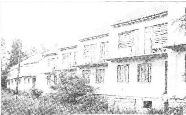
Niewykończone domki pod lasem.
