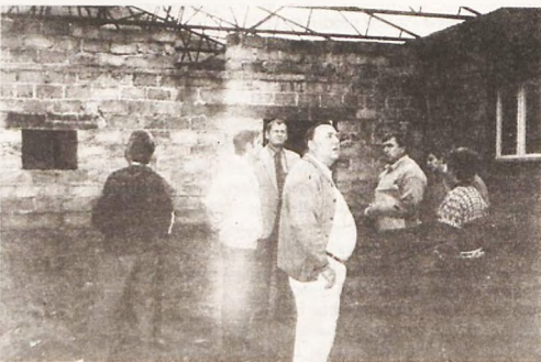
Władze gminy na terenie budowy remizy
