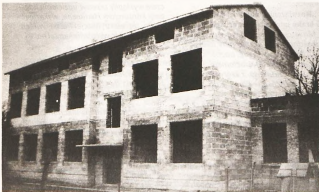
Dobudowywany segment szkoły w Skarżynie
