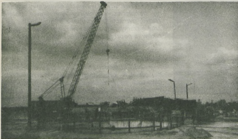
Oczyszczalnia w budowie
