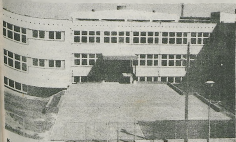
Na przełom pesymistycznym prognozom, wbrew opinii niedowiarków, że budowa skończy się za kilka lat, w dniu 1 września Szkoła Podstawowa nr 5 rozpocznie prace (wywiad z dyrektorem szkoły oraz historia budowy na str.5)
