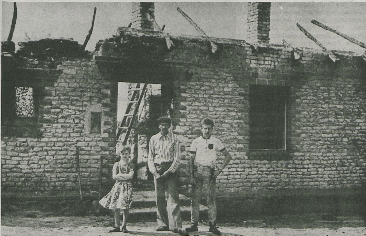
Spalony dach, zniszczone mury, oto co pozostało rodzinie Kowalskich
