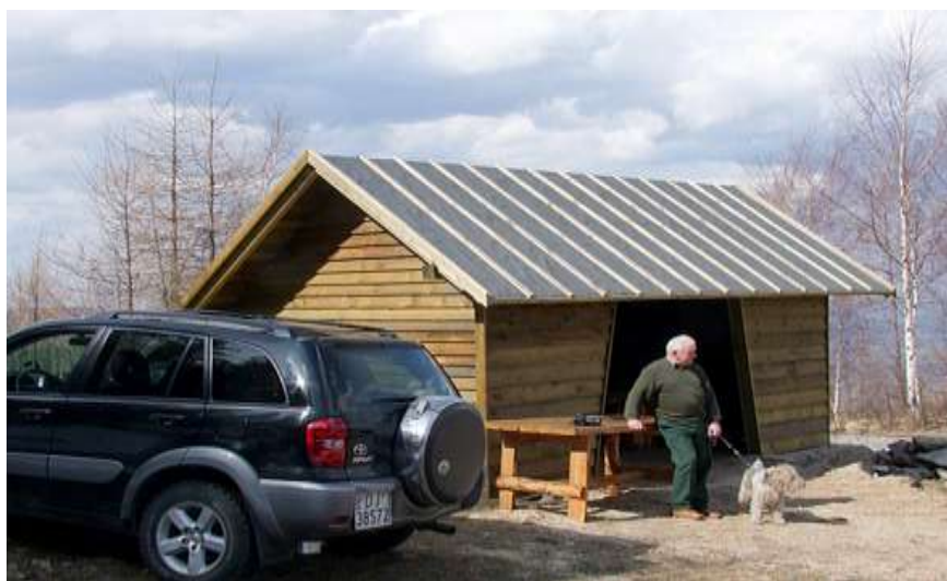
Wiata pod Skalnym Stołem wybudowana przez członków koła.
