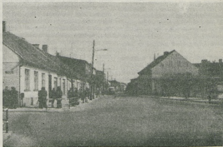
Widok na ulicę Kaliską (początek lat siedemdziesiątych) zdjęcie ze zbiorów Sylwina Jafry
