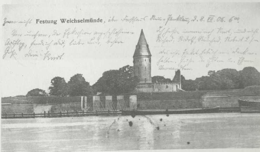
8. Twierdza Wisłoujście na początku XX wieku z lewego brzegu Wisły. Widoczna Latarnia, Wieniec oraz załamana kurtyna północno-zachodnia Fortu Carré. Wieżę zwieńczono stożkowym hełmem po pożarze w 1889 r. Pocztówka sprzed 1906 r.
