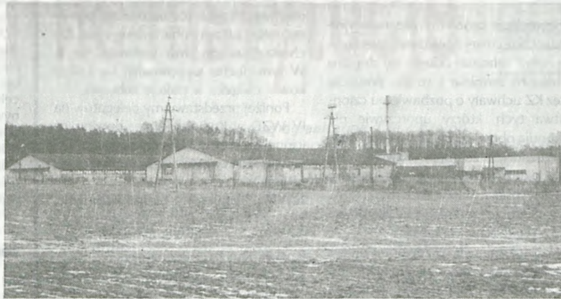
Powierzchnia terenu — 2,8 ha, powierzchnia użytkowa — 8 100m 2 w tym trzy hale (3171m 2 ), magazyny, warsztaty i budynek socjalny
