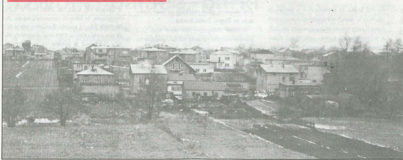
Malanów rozbudowuje się intensywnie. Obok dwóch osiedli domków jednorodzinnych oraz nowego, murowanego kościoła trwają tu jeszcze prace przy budowie kilku innych obiektów
