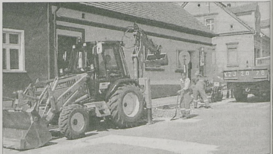
Prace na ulicy Jarocińskiej powinny zakończyć się już wkrótce
