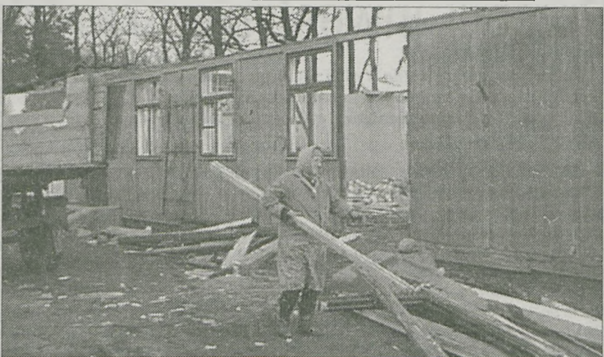
Rozpoczęła się rozbiórka baraków przy ul. Poznańskiej w Jarocinie. Lokatorzy zostali przeniesieni do mieszkań zastępczych Fot. Robert Kaźmierczak
