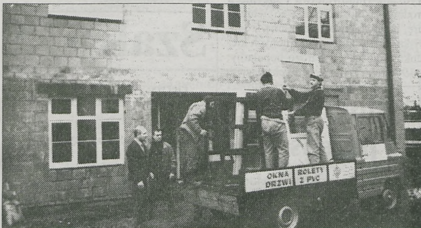
Montaż okien zamknął stan surowy nowego budynku szkoły w Jaraczewie
