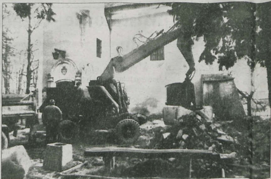
Trwają prace remontowe nad odtwarzaniem zabytkowych piwnic jarocińskiego Skarbczyka. W tej chwili ekipy remontowo - budowlane wydobywają z nich ziemię. Na wiosnę przeprowadzona zostanie inwentaryzacja. Przygotowany zostanie także zakres dalszych prac remontowych
