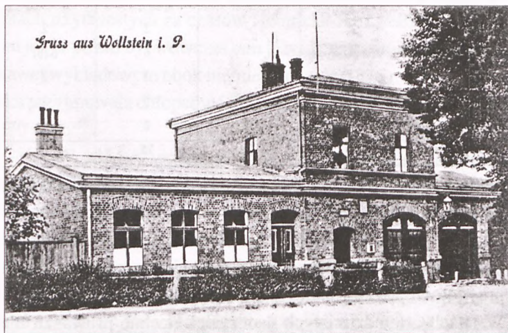
Ryc. 13. Budynek Ochotniczej Straży Pożarnej
