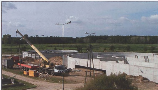
Prace przy modernizacji gminnej oczyszczalni. Ze zbiorów autorki
