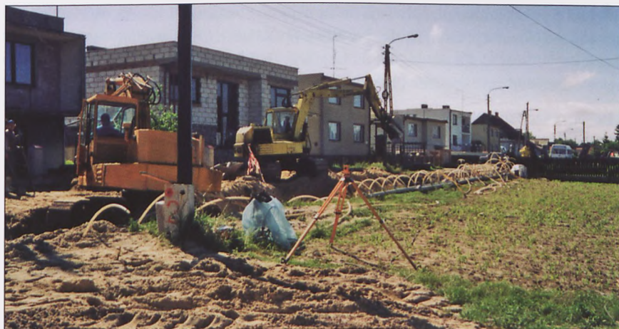
Budowa kolektora ściekowego. Ze zbiorów autorki
