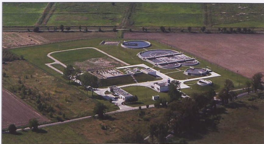
Gminna Oczyszczalnia Ścieków w Komorowie. Widok z lotu ptaka. Ze zbiorów autorki
