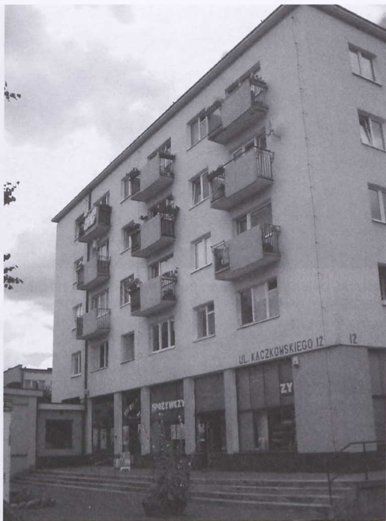
Fot. 253. Modernistyczny budynek mieszkalny z pierwszej połowy lat sześćdziesiątych, ul. Kaczkowskiego 12. Przy lewej krawędzi zdjęcia widoczny fragment pawilonu, mieszczącego niegdyś kawiarnię „Kosmos”./MG
