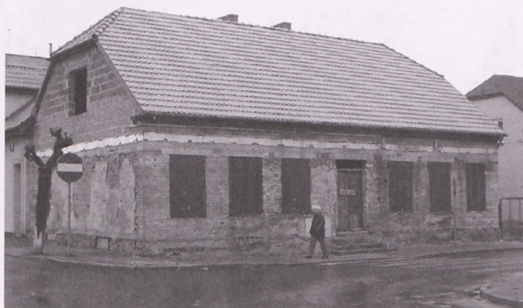
Fot. 146, 147. Wymiana pokrycia dachowego, otworów okiennych, nowe tynki i uproszczenie wystroju – to negatywny efekt XX wiecznych modernizacji. Współczesna odbudowa i przebudowa domów tkackich stwarza nowe możliwości rekonstrukcji ich dawnego charakteru. / MG.
