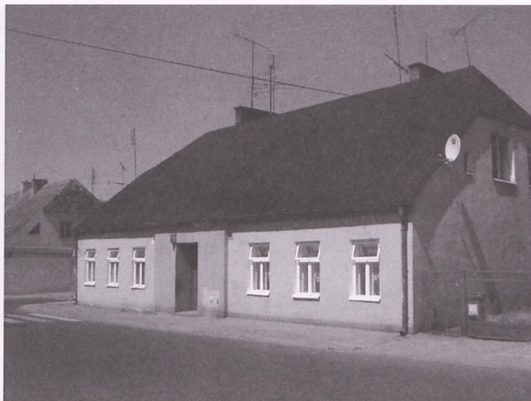
Fot. 146, 147. Wymiana pokrycia dachowego, otworów okiennych, nowe tynki i uproszczenie wystroju – to negatywny efekt XX wiecznych modernizacji. Współczesna odbudowa i przebudowa domów tkackich stwarza nowe możliwości rekonstrukcji ich dawnego charakteru. / MG.
