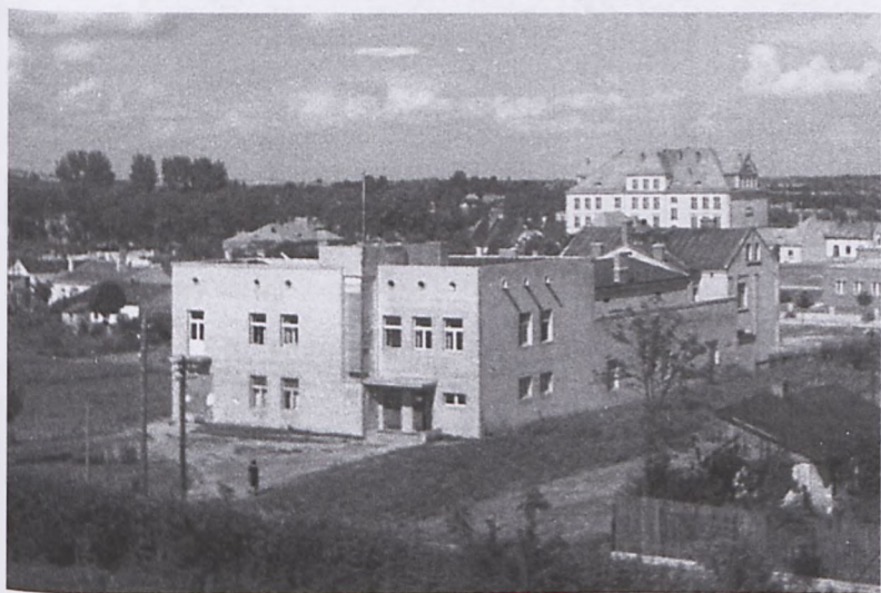
Fot. 198, 199. Dwa zdjęcia, dwie fazy budowy „Domu Strzelca”. Na ujęciu górnym widzimy położenie budowli na sztucznej skarpie i pawilon z 1934 roku; poniżej widok nowej, „doklejonej” części (II wojna światowa) / MRzT Na kolejnej stronie: Fot. 200. Budowla jako „Deutsches Haus”, druga wojna św /MRzT.
