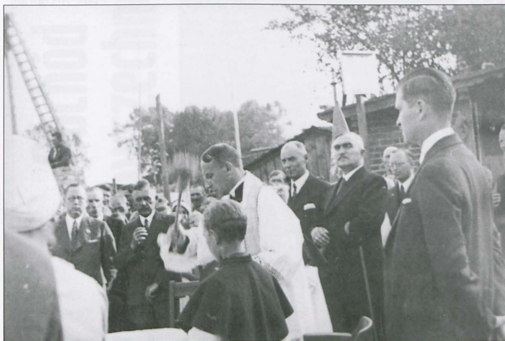
Ks. Henryk Koppe, proboszcz parafii w Puszczykowie, poświęca kamień węgielny pod nowo budowaną szkołę
