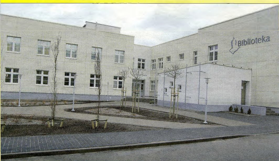
GRUDZIEŃ 2014 - Podczas kilkumiesięcznych prac modernizowana została elewacja budynku. Na zewnątrz przebudowano chodniki oraz parkingi. Posadzone zostały również nowe drzewa i krzewy.
