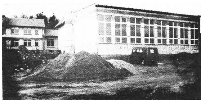
Budowa sali gimnastycznej przy Szkole Podstawowej w Kleńcu zakończy się w maju. Więcej na temat szkolnych remontów i inwestycji w jednym z najbliższych numerów „Gazety” FOTO Stachowiak
