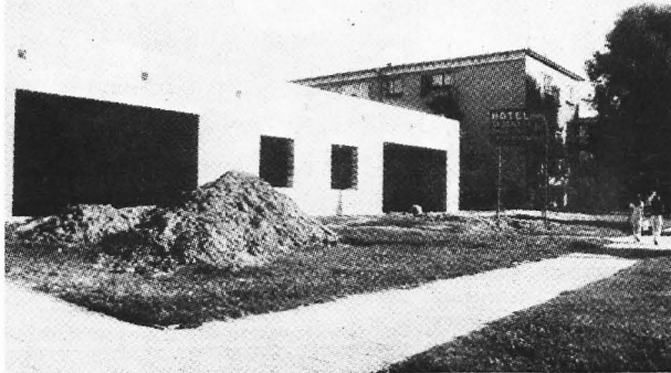
Budowa nowej siedziby ELMONTU na os. 1000-lecia
