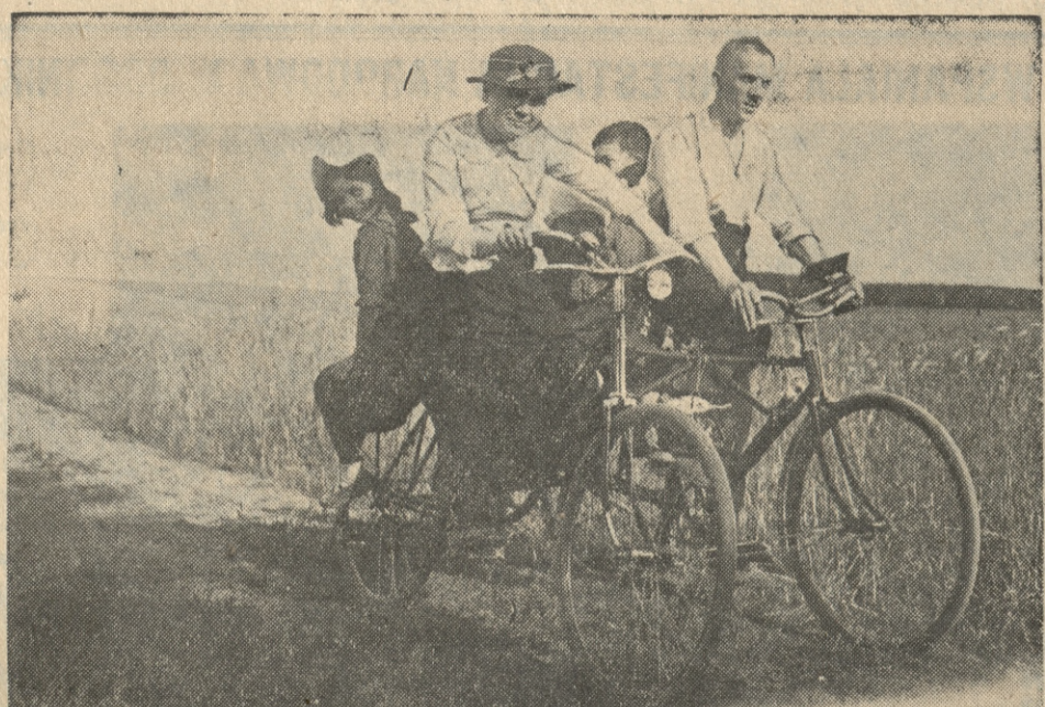
P. Leon Kłowski z Poznania (ul. Wronecka 19) wpadł na pomysł połączenia dwóch rowerów przy pomocy kilku metalowych poprzeczek i stworzył w ten sposób widoczny na fotografii praktyczny pojazd, którym co niedzielę wyjeżdża z rodziną za miasto.
