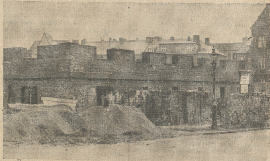
Budowa domu dla inteligencji Fundacji Twardowskich
