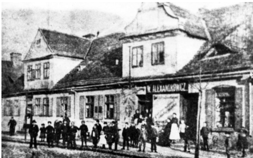
Pierwsza siedziba Banku Ludowego w Grodzisku Wielkopolskim (pierwszy budynek od prawej strony – obecnie ul. Szeroka)
